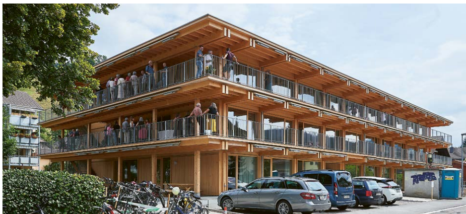
Von mehrheitlich lokalen Handwerkern mit lokalem Baustoff gebaut: Das Generationenhaus Langnau in Emmental.
