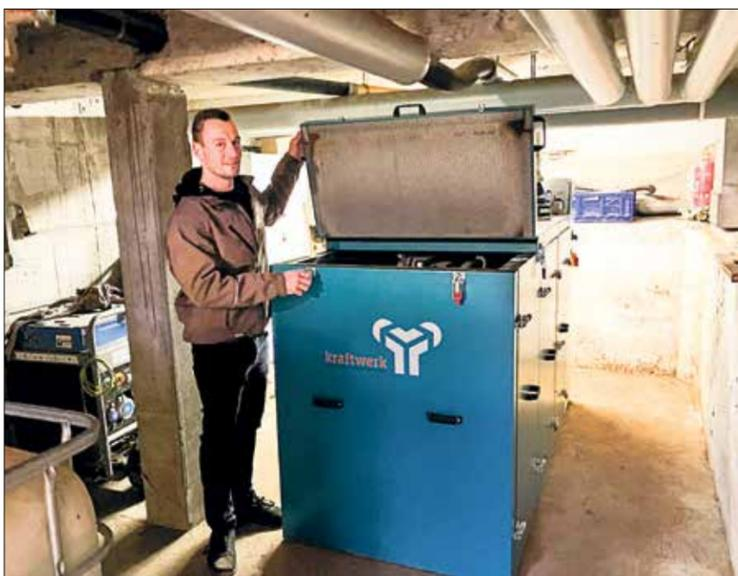
Adrian Gerber beim Herz der Biogasanlage. Hier verwandelt ein Motor das Biogas in Strom und Wärme.
